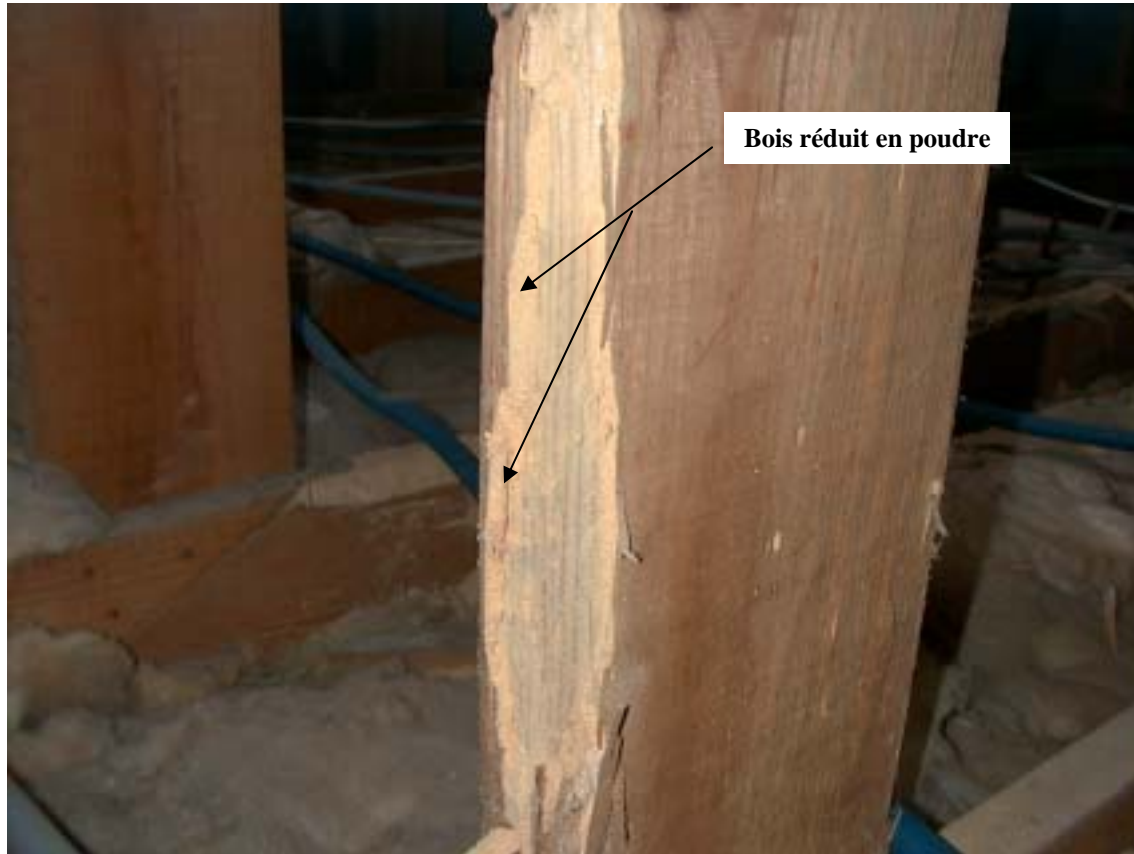
Exemple caractéristique d'attaque par le capricorne
